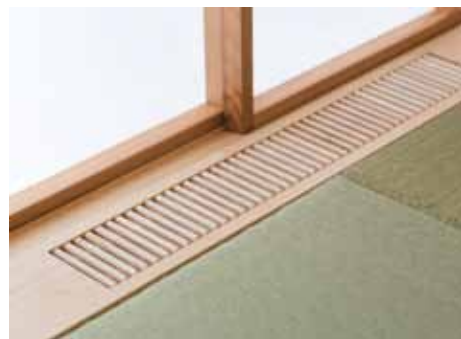
全館空調の床下吹き出し口には木製の格子組を使用しました。
