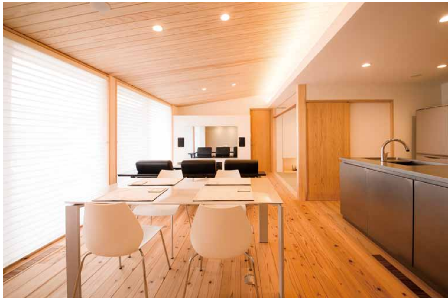
床は木目の立体感を生かした、癒し効果のある浮遊り加工の杉を使用。サッシや建具にいたるまで高さをそろえてスッキリと見せています。
