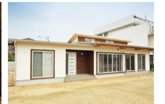
当初は長方形のボックスのような外観だったが、それではメリハリがないと一部天井を高くしてアクセントに。
